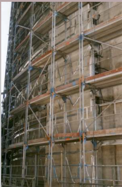
...Zuckersilo in Wierthe ...Durchmesser 47,5 m, Höhe 40 m, 12.000 m Kabel ...Sugar silo in Wierthe ...Diameter 47.5 m, height 40 m, 12,000 m cable
